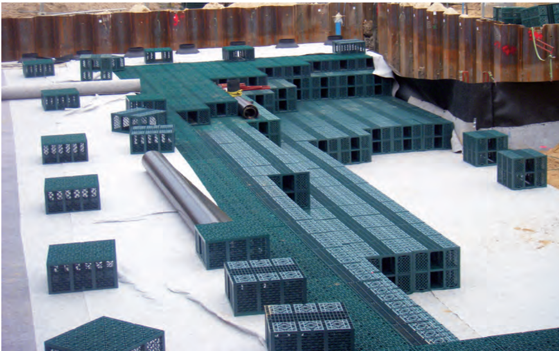
Füllkörper-Zisternenanlage maximat VarioCollect
